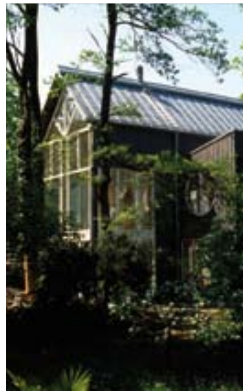
Abb. 4.22: Die Holzfassade verstärkt die natürliche Atmosphäre des Ortes
