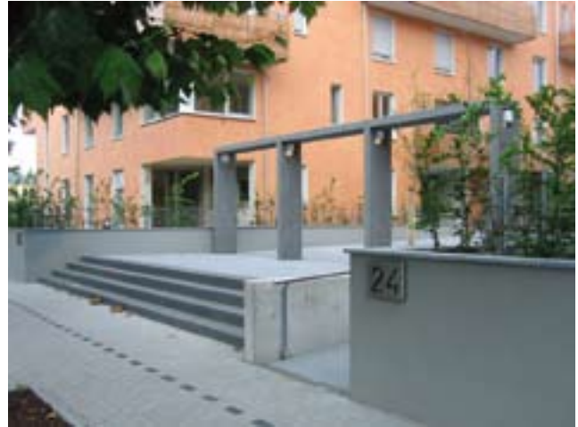
Abb. 4.12: Inszenierter Übergang in eine halböffentliche Quartierserschließung
