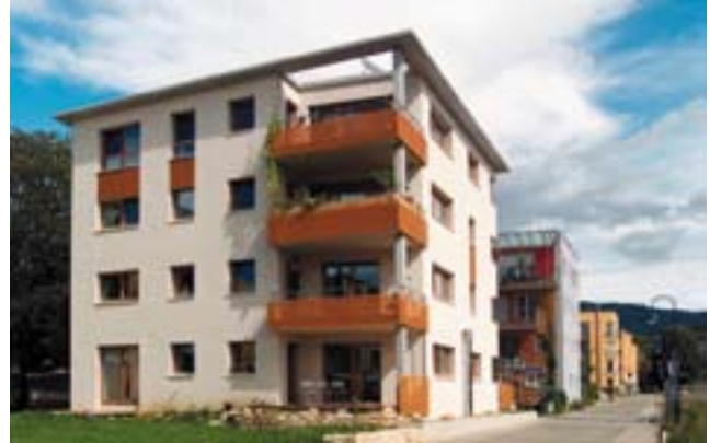
Abb. 4.25: Die Baugruppe „Sunnyside“ in Freiburg lebt in einem schlichten Punkthaus mit stadträumlich markant aufgelöster Loggien-Ecke
