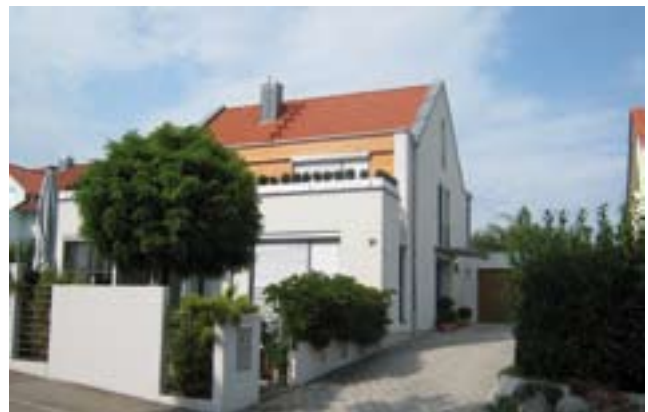
Abb. 4.24: Einfamilienhaus am Wieselweg in Ludwigsburg
