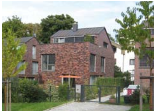
Abb. 4.21: Einfamilienhaus im Albert-Schöchle-Weg in Ludwigsburg
