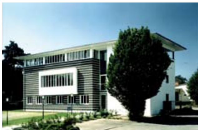
Abb. 4.6: Materialwechsel gliedern den Baukörper - das Dach fasst zusammen
