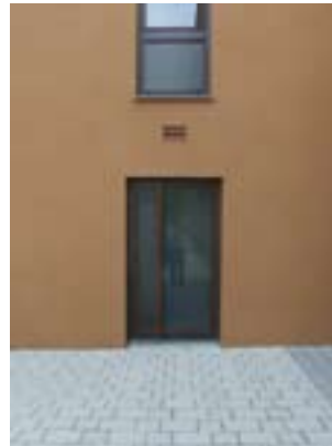
Abb. 4.16: In Gebäudestruktur integrierter, von außen zugänglicher Müllbehälterstandort
