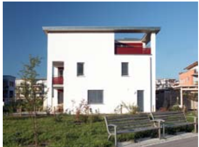
Abb. 4.18: Die plastisch gestaltete Loggien-Ecke dieser Baugruppe wird zum Merkzeichen für ein Quartier
