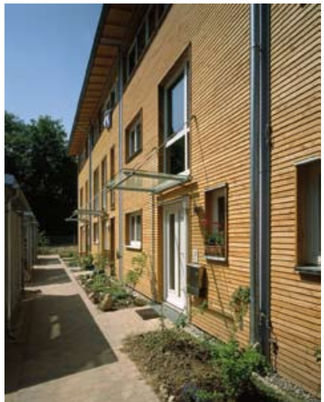
Abb. 3.6: Wohnweg mit „Fenster zum Hof“ und einladenden Hauszugängen sowie zugeordneten, einheitlich gestalteten Nebengebäuden
