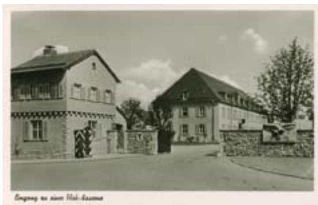
Abb. 2.6: Eingang zur Flakkaserne auf der Westseite mit Wachhaus und Stabsgebäude in den 1930er Jahren
