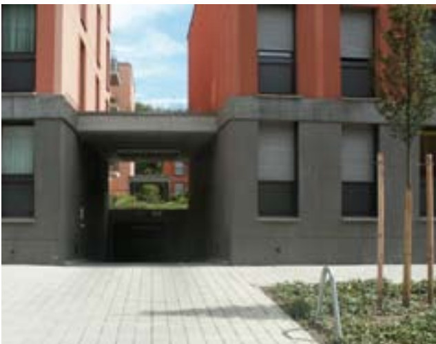
Abb. 4.4: Die harmlos in einer Gebäudefuge angeordnete Tiefgaragenzufahrt rahmt den Blick in den begrünten Innenhof
