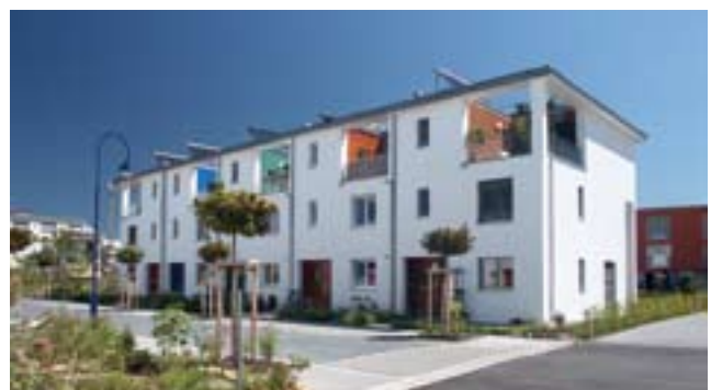
Abb. 4.17: Bei dieser Baugruppe in Freiburg werden Loggien durch einen umlaufenden Dachüberstand spielerisch in das klare Baukörpervolumen integriert. Eingänge prägen den öffentlichen Raum
