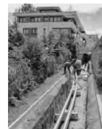
Bau der Fernwärmeleitung (→ S. 133, 156f)
