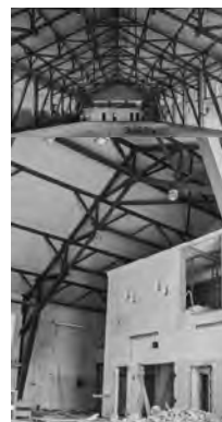
Umbauarbeiten in der Turnhalle; gut zu erkennen: die zu erhaltende Deckenkonstruktion (→ S. 18, 80, 86, 125, 141)
