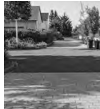
Straßenbelagswechsel in der Elisabeth-Kranz- Straße (→ S. 156)
