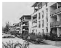
Sockelmauern und Dachvorsprünge in der Cäsar-von-Hofacker Anlage (→ S. 28, 78, 87, 93, 110)
