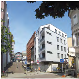
Projektträger: Bauherrengemeinschaft „WaldhornEck“, Karlsruhe
