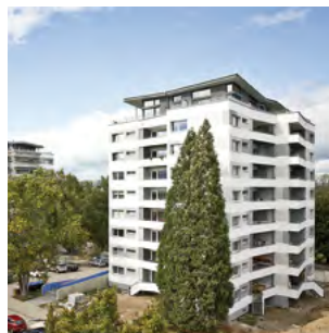
Projektträger: Baugenossenschaft Hegau eG, Singen
