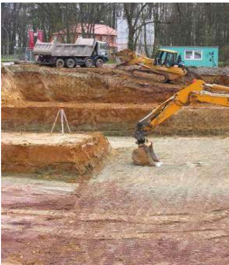
Abb. 3a: Baugrube in Ludwigsburg am Salonwald.
