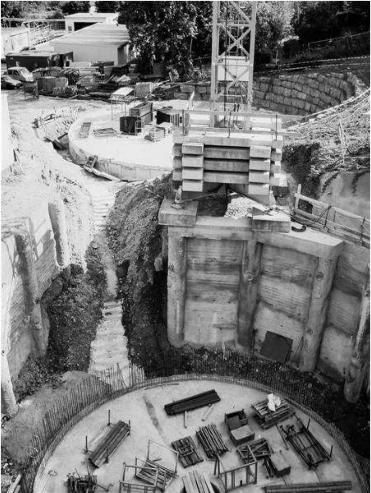
Die Baugruben der 2 Faultürme und die Bodenplatte des Gasbehälters im Überblick: Oben rechts neben dem Gasbehälter wird der Hang durch Blocksteine gesichert. Der Baustellenkran sitzt auf Bohrpfehlen der Pfahlwand für die Baugrube der Gasbehälter. Diese ungewöhnliche Anordnung wurde statisch berechnet und als standsicher bewertet.
