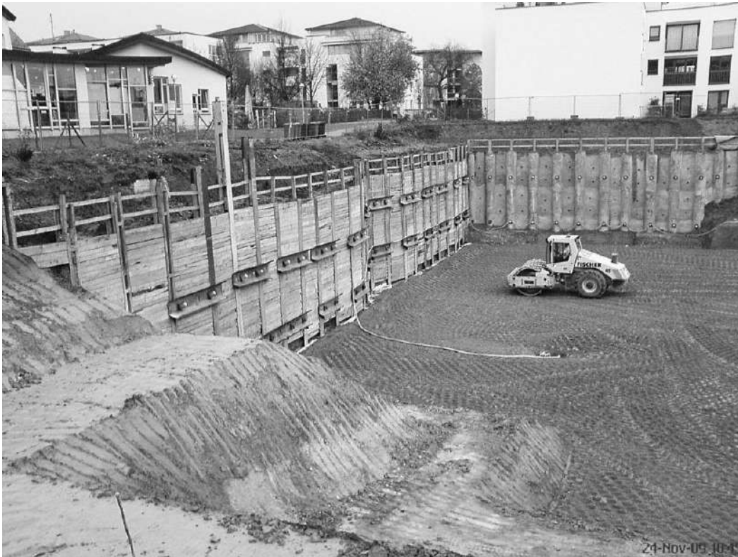
Bildtafel 14: Altlastensanierung auf dem MLF-Gelände (2009 - 2010)
